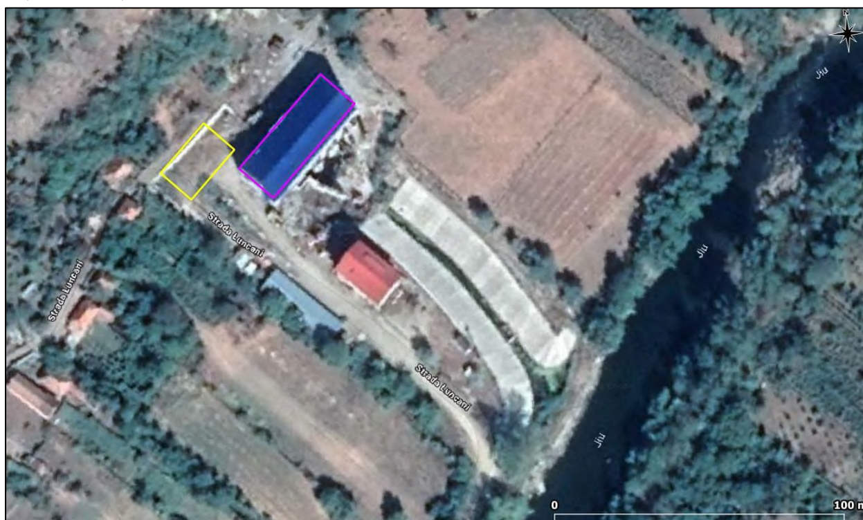
Fig. 39 Încadrarea în teritoriu a clădirii CHE Bumbesti (poligon de culoare mov) și a stației de transformare 110 kV CHE Bumbesti (poligon de culoare galbenă)
