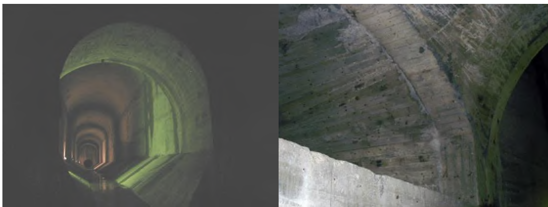
Fig. 13 Imagini din interiorul decantorului betonat
