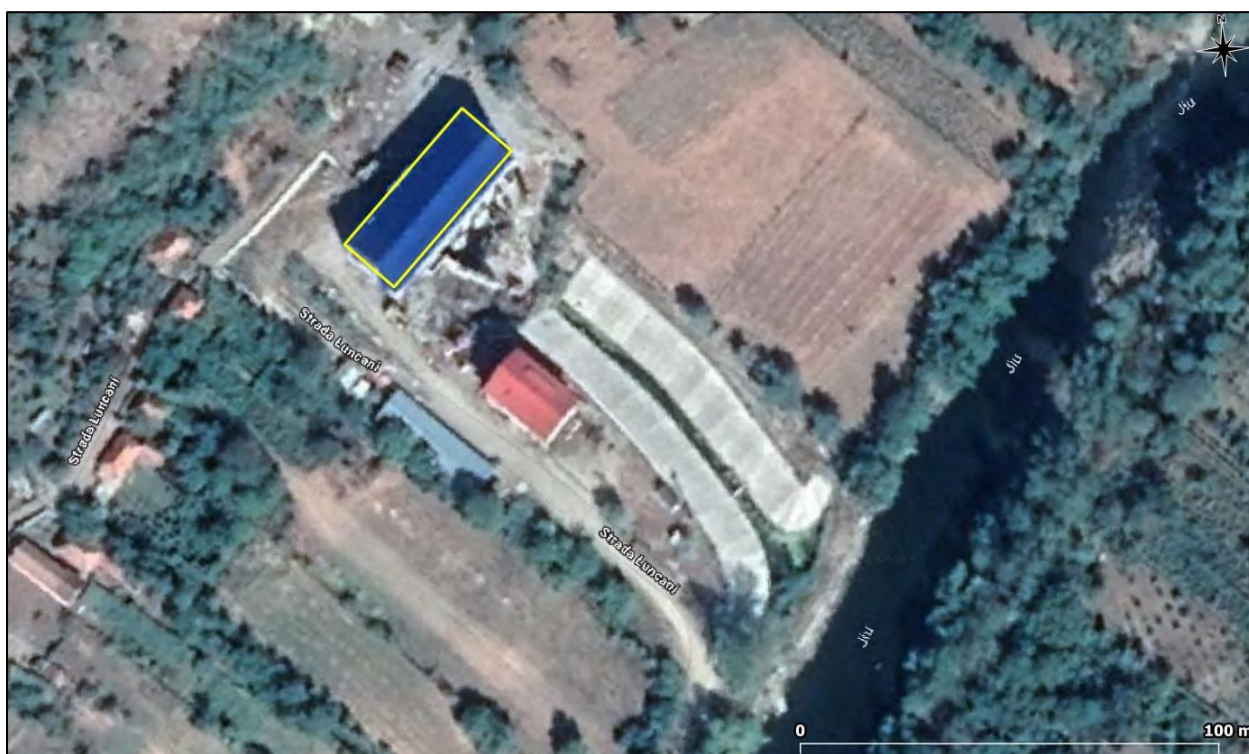
Fig. 36 Încadrarea în teritoriu a clădirii CHE Bumbesti (perimetru de culoare galbenă)
