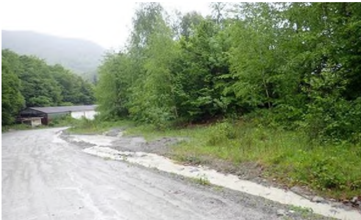
Fig. 180 Apa tulbure care intră în pârâul Bratcu de la nivelul carierei Meri (în cazul unei ploi), în apropierea confluenței pârâului Bratcu cu Râul Jiu
