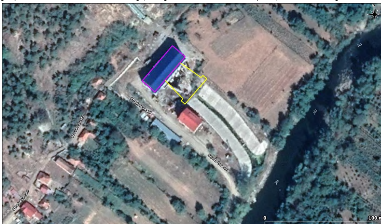
Fig. 38 Încadrarea în teritoriu a clădirii CHE Bumbești (poligon de culoare mov) și a zonei de racord dintre bazinul de liniștire al CHE Bumbești și canalul de fugă (poligon de culoare galbenă)
