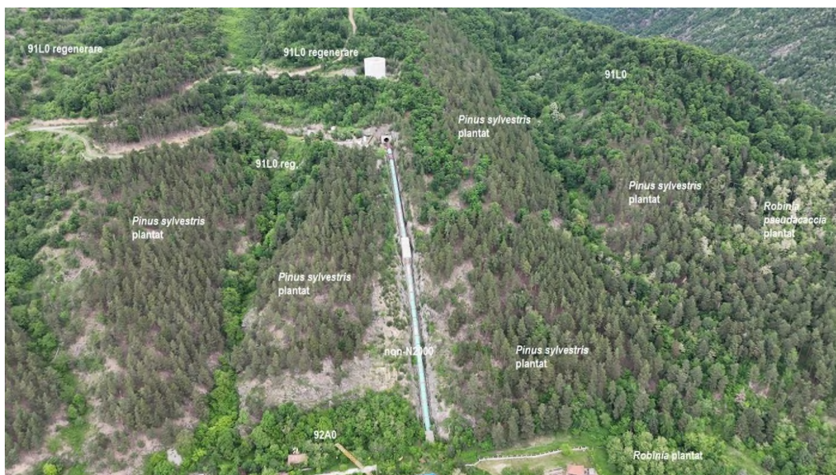
Fig. 91 Detaliu asupra habitatelor N2000 și non-N2000 de pe rama sudică montană, în care se află încastrată CHE Bumbști
