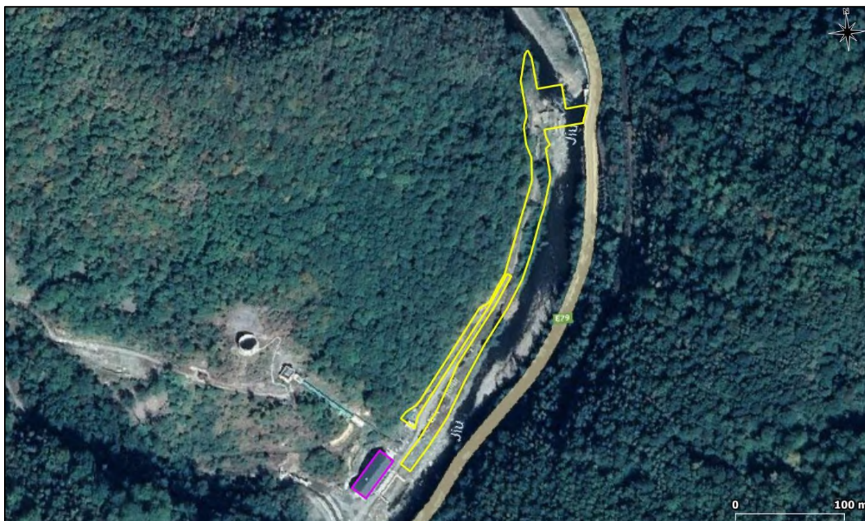
Fig. 43 Încadrarea în teritoriu a captării secundare Jiu – inclusiv traseu conductă aducțiune și drum de operare (poligon de culoare galbenă); clădirea CHE Dumitra (poligon de culoare mov)
