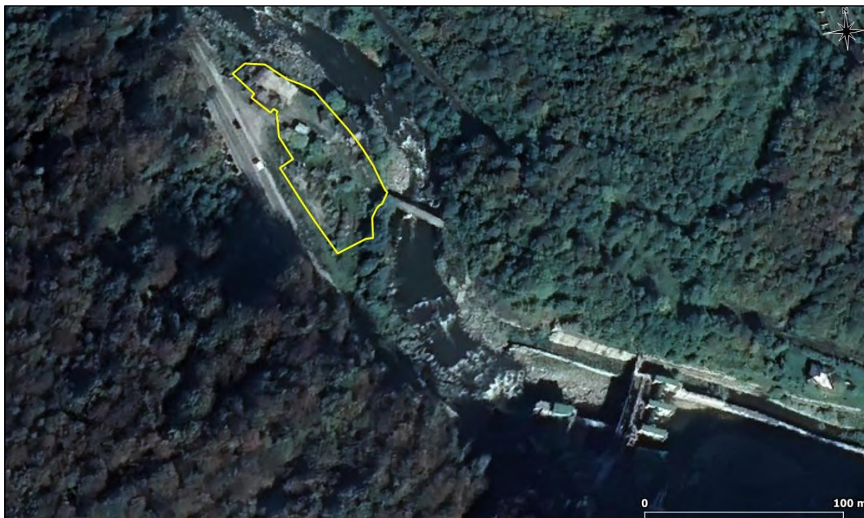
Fig. 45 Încadrarea în teritoriu a platformei tehnologice situate amonte de baraj Livezeni (poligon de culoare galbenă), vizată de lucrări de dezafectare
