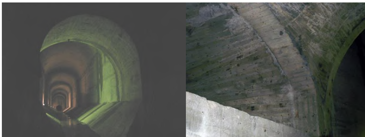
Fig. 18 Imagini din interiorul decantorului betonat
