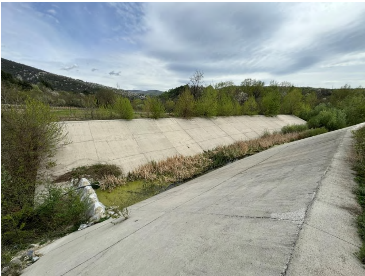
Fig. 115 Habitat acvatic în structură antropică (CHE Bumbesti)
