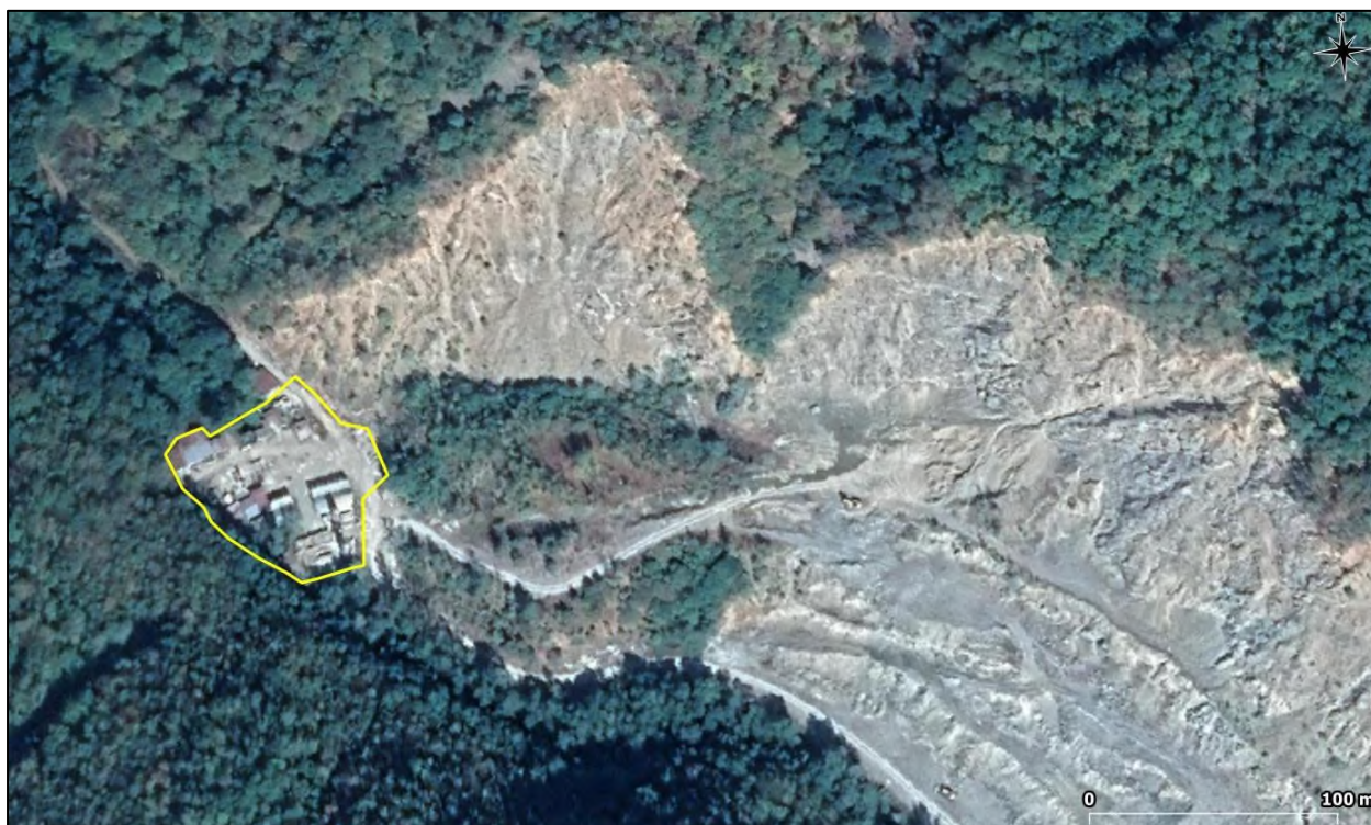
Fig. 48 Încadrarea în teritoriu a organizării de șantier de la Fereastră Bratcu (poligon de culoare galbenă), obiectiv vizat de lucrări de dezafectare
