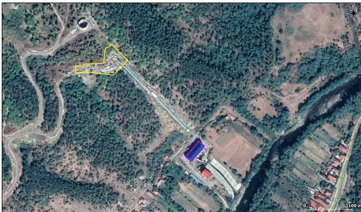
Fig. 35 Încadrarea în teritoriu a clădirii CHE Bumbești (poligon de culoare mov) și a casei de vane (poligon de culoare galbenă)
