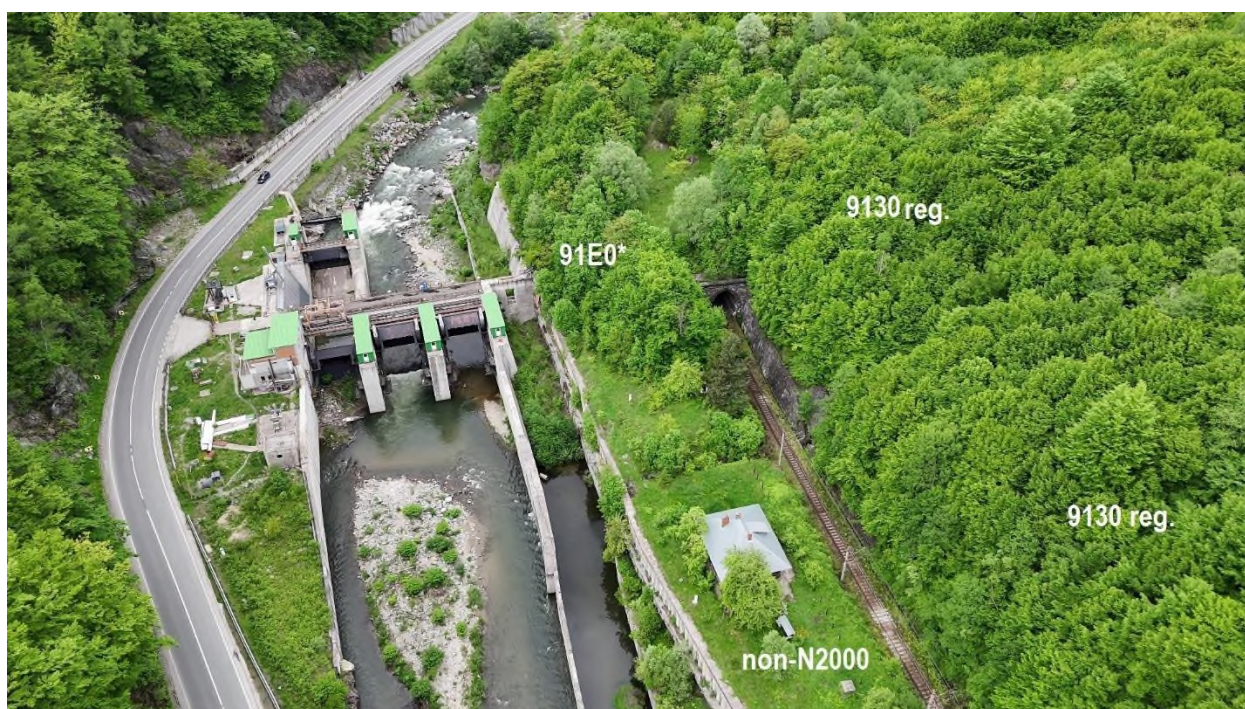
Fig. 71 Distribuția locală a habitatelor forestiere N2000 în perimetrul barajului Livezeni. Se constată lipsa habitatelor neforestiere N2000 în perimetru
