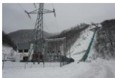
Hidrocentrala Raul Alb
