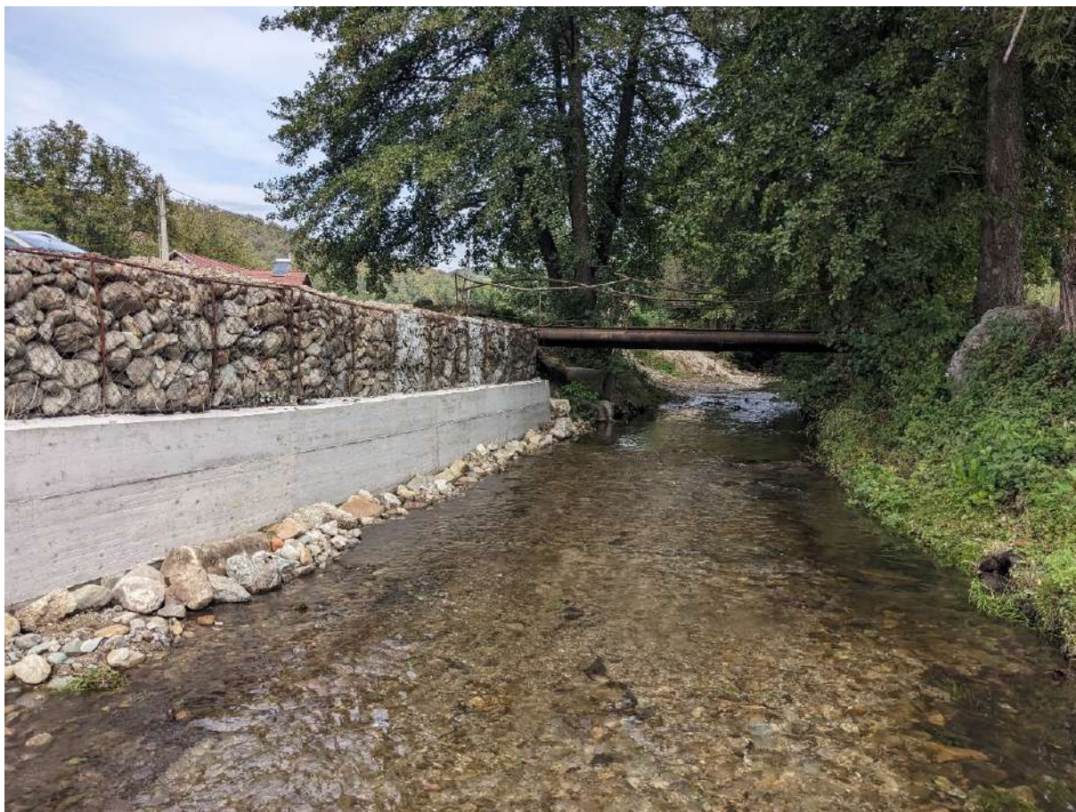
Foto 24 Sectorul Tismana Amonte Baraj
